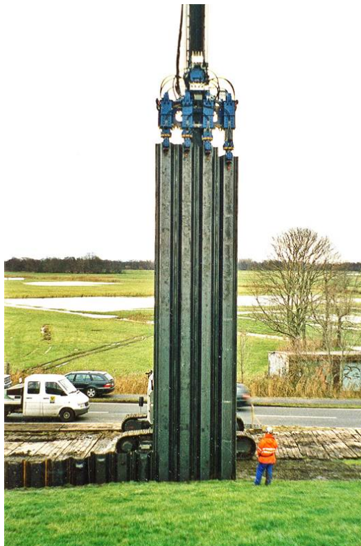
Abb. 4. Pressung der 15 bis 25 m langen Stahlspundbohlen.
