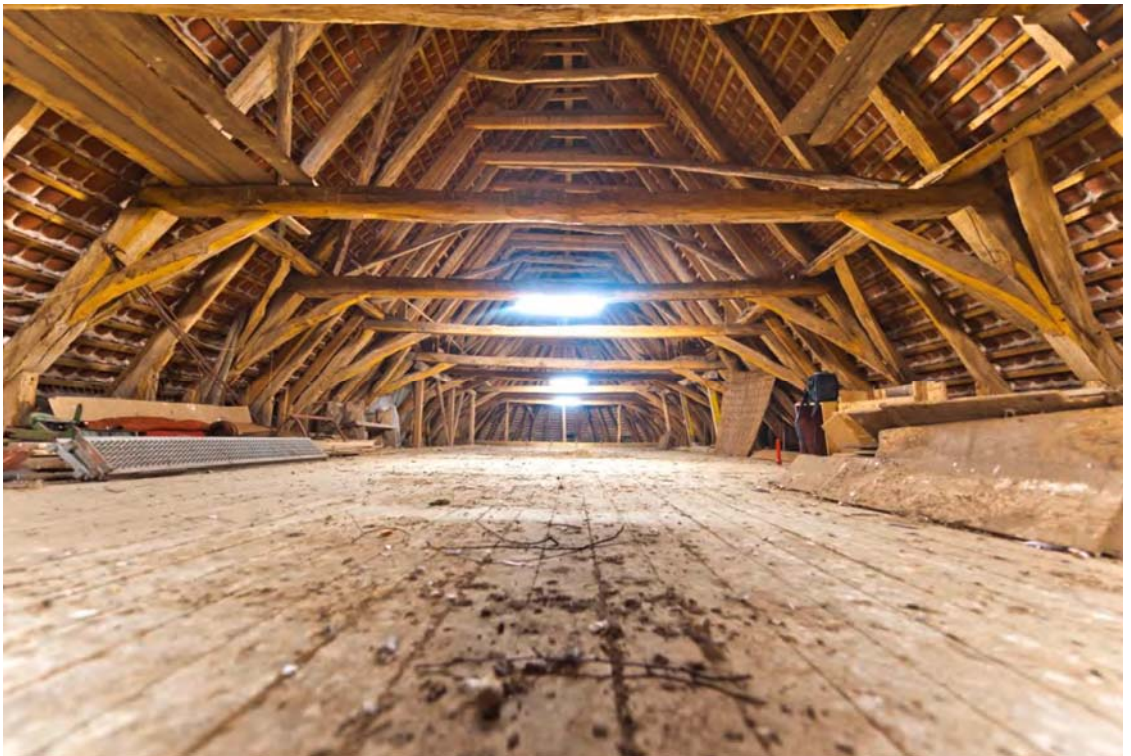
Abb. 1. Die Kirche in Reepsholt und ihr Dachwerk.
