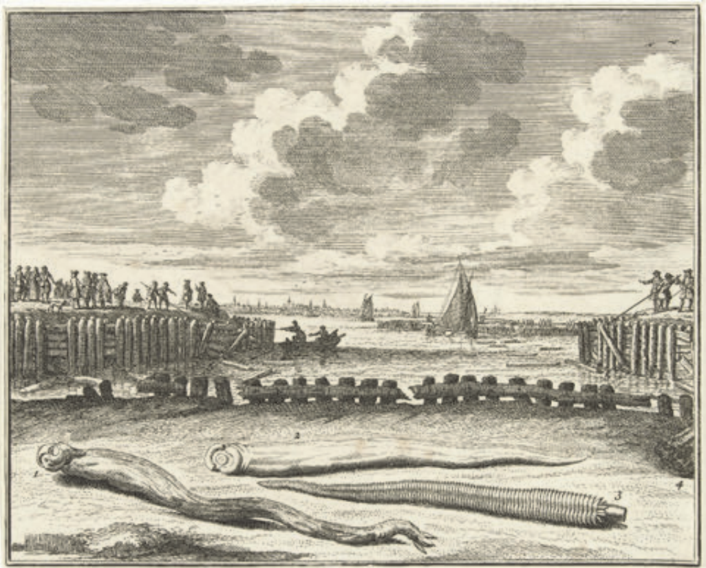
Abb. 5. Abraham Zeeman (1731-1733): Pfählwürmer, die einen holländischen Stackdeich anfressen, der schon umbricht. Aus Bartels u. a. 2015.
