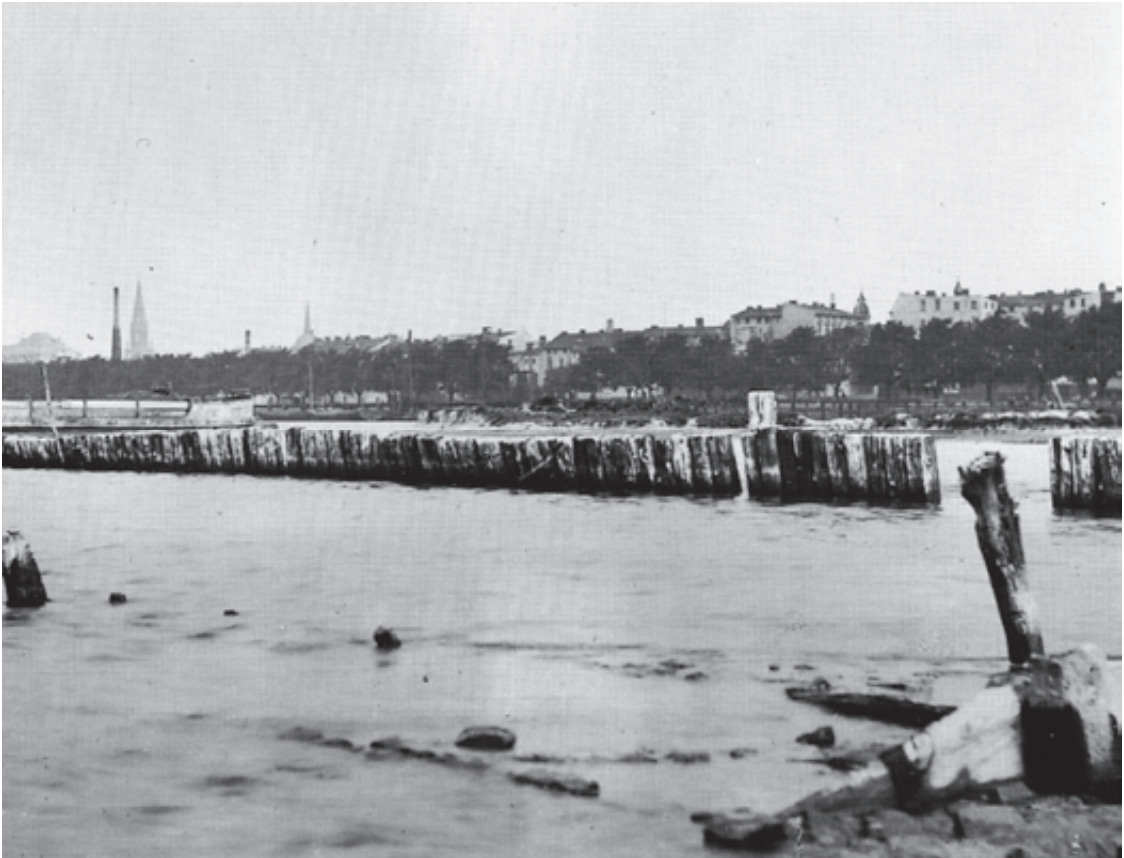
Abb. 4. Teil der um 1650 gebauten mächtigen Edo-Lammers-Holzung, die 1905 beim Hafenbau in Wilhelmshaven freigelegt wurde. Aus Reinhardt 1996.
