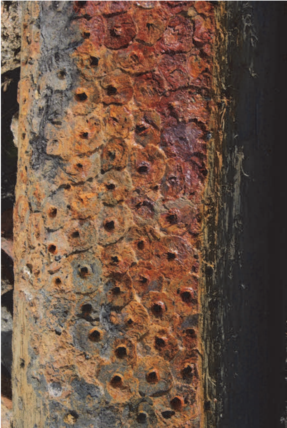
Abb. 6. In einen Pfahl eingeschlagene breitköpfige Nägel, die schuppenartig zusammengerostet sind und eine Schutzhaut liefern (Medemblik, ca. 1734). Aus Bartels u. a. 2015.
