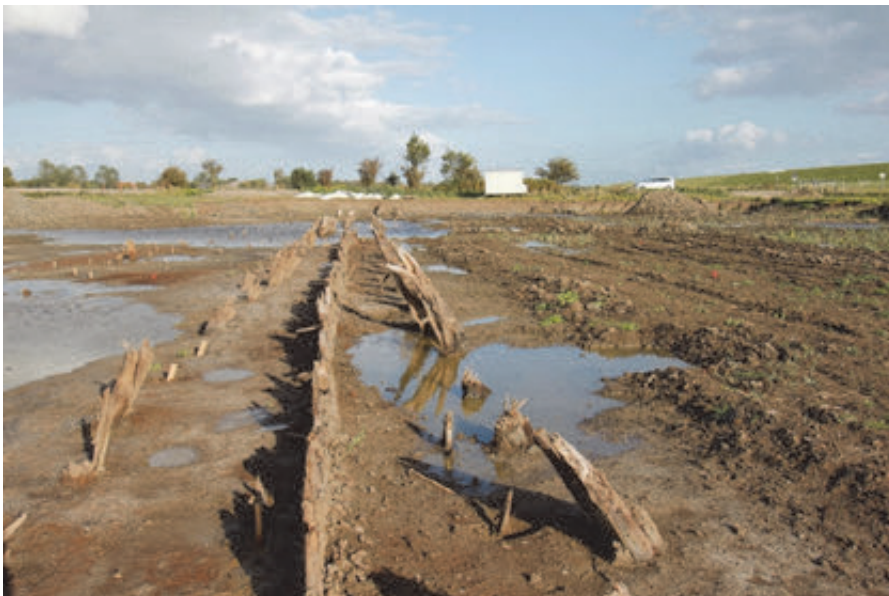
Abb. 2. Ein über 300 m langes Stück eines Stackdeiches wurde 2012 beim Abbau von Deicherde bei Jarßum südöstlich Emden entdeckt. Bei dieser Konstruktion wird eine Bohlenwand beidseitig von schrägen Pfosten gestützt. Foto König.
