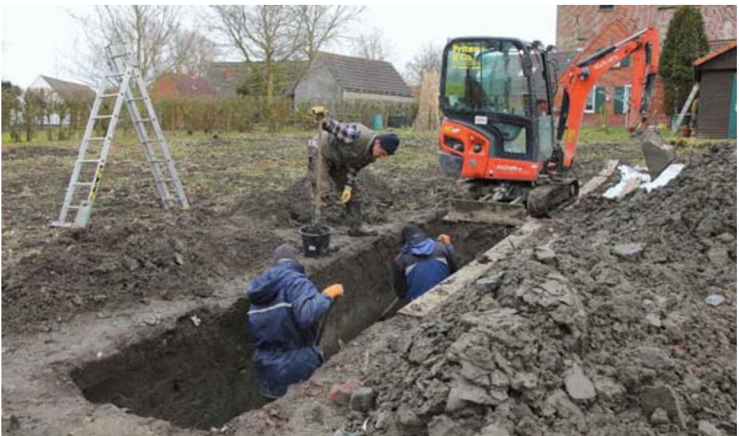
Abb. 4. Mit einem Minibagger durchgeführte Sondagen vor der Wurt Groothusen erbrachten den Nachweis ehemaliger Wasserwege (Foto: J. Ziegler, NlHK).
