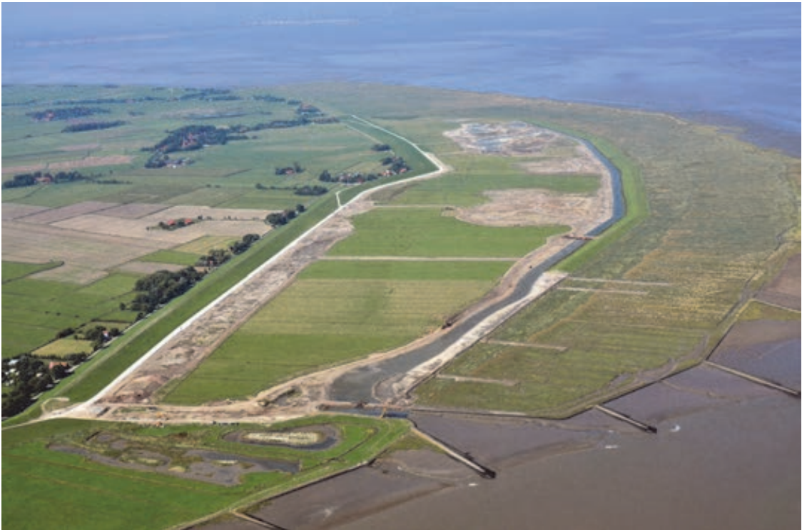
Abb. 12. Luftbild Langwardergroden kurz vor Ende der Baumaßnahme im Spätsommer 2014.
