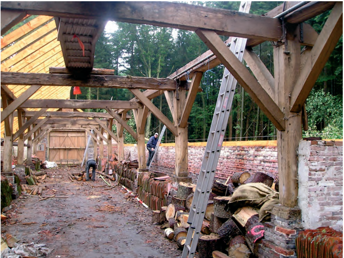
Abb. 8. Restaurierung des historischen Schafstalls 2011. Den Ausschlag für die Unterschutzstellung gab das gut erhaltene Eichenständerwerk (Foto: G. Hoinke).
