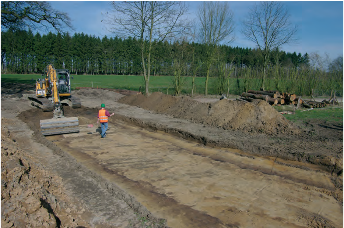
Abb. 2. Anlage des Planums im Bereich des östlichen Flügelwalls. Blick nach Nordosten (Foto: NLD Oldenburg).
