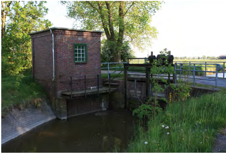
Abb. 8. Schöpfwerk Burhave mit Verlaat am Zuwässerungskanal (Foto: Klaas-H. Peters).
