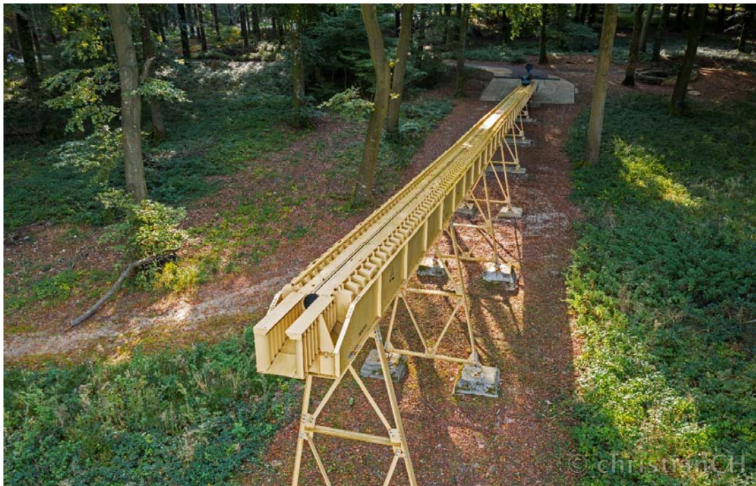
Abb. 1: Rekonstruierte Walter-Rohrschleuder mit V1-Replik in der V1-Feuerstellung 161, Poteau Montauban bei Melleville, Département Seine-Maritime, Frankreich. Im Hintergrund das Hauptfundament der auf acht Pendelstützen aufliegenden Rampe (Foto: Chr. Kleis).
