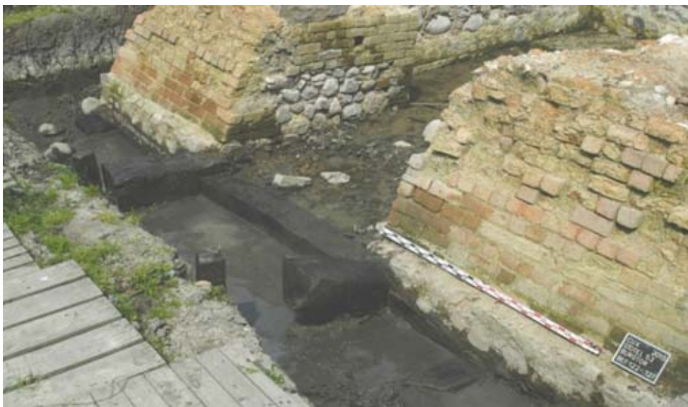
Abb. 3. Torfundament. Ansicht von Südosten.
