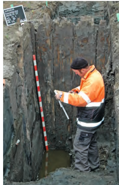
Zur Fundamentierung des Stackdeichs von Jarssum hat man im 16. und 17. Jh. aus Skandinavien importierte Spaltbohlen mehr als 2 m in den Kleiboden gerammt.
