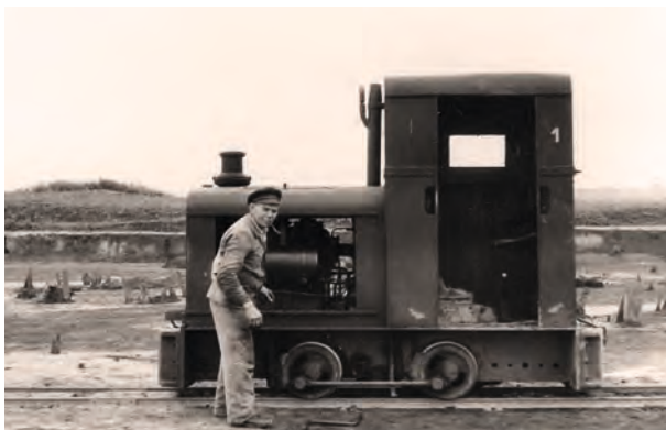
Lok und Loren sorgten für den Abtransport des Aushubs.
